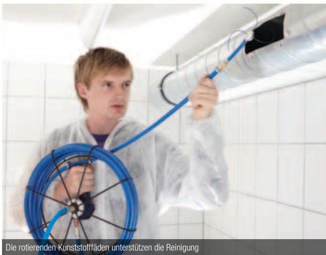
Mit der Wöhler DH 420 Drucklufthaspel können bis zu 10 m lange Abschnitte bearbeitet werden
