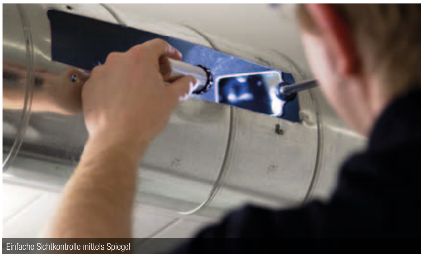
Funktionskontrolle an Luftdurchlässen
