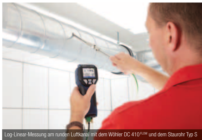
Volumenstrommessung und Einregulierung von Ventilen über k-Wert-Eingabe
