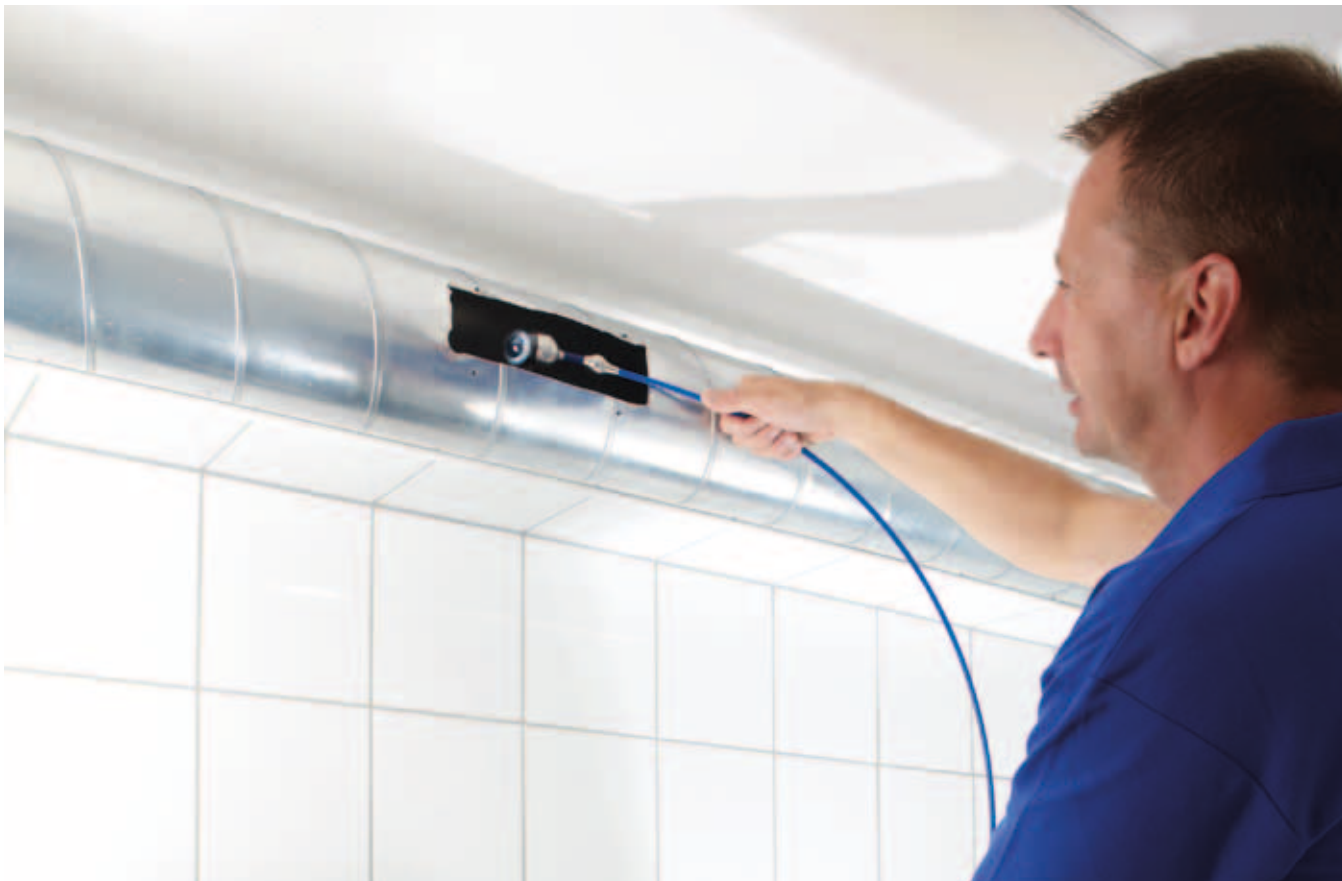
Videoinspektion mit der Wöhler VIS 350 Videoinspektionskamera
